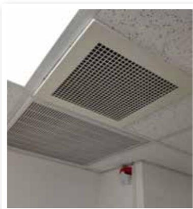
圖一 定時換氣抽風機
